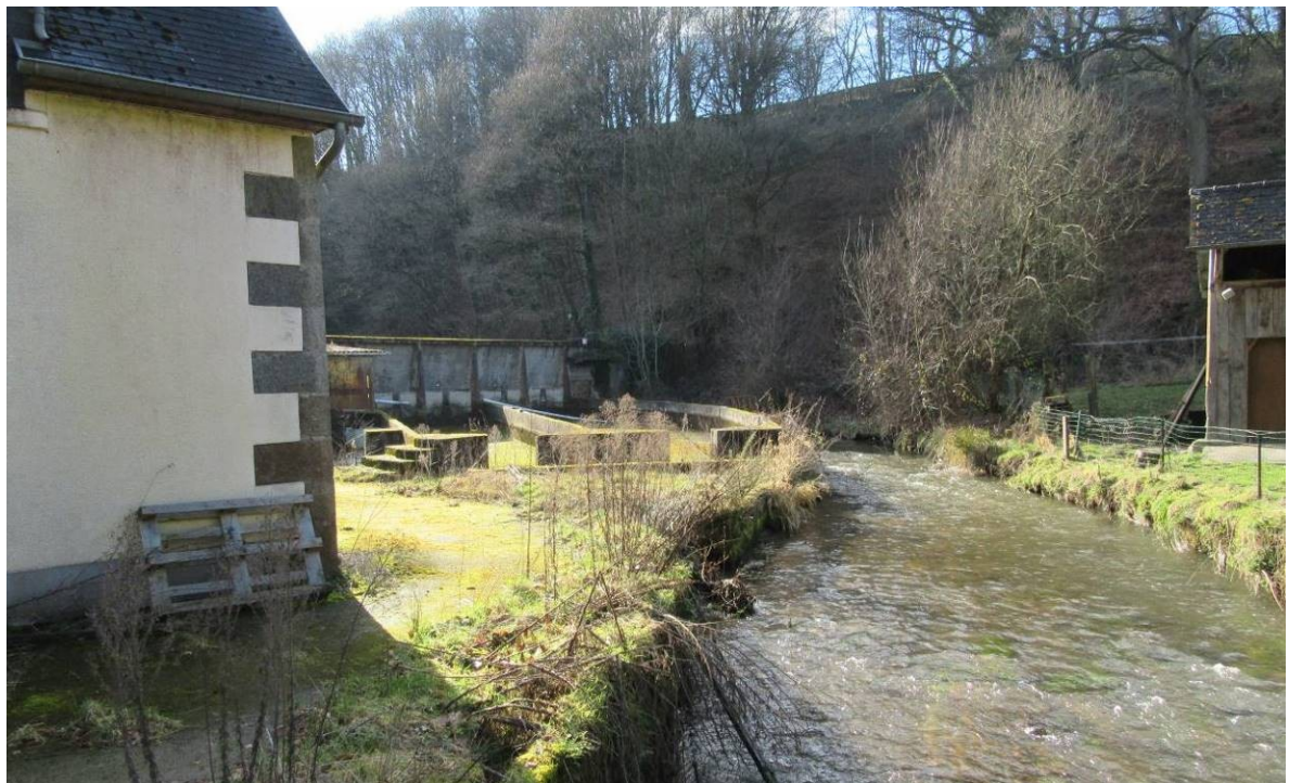
Pisciculture désaffectée à Saint-James, lieu-dit Valjoie (Photo : SEPIA Conseils, 2017)
